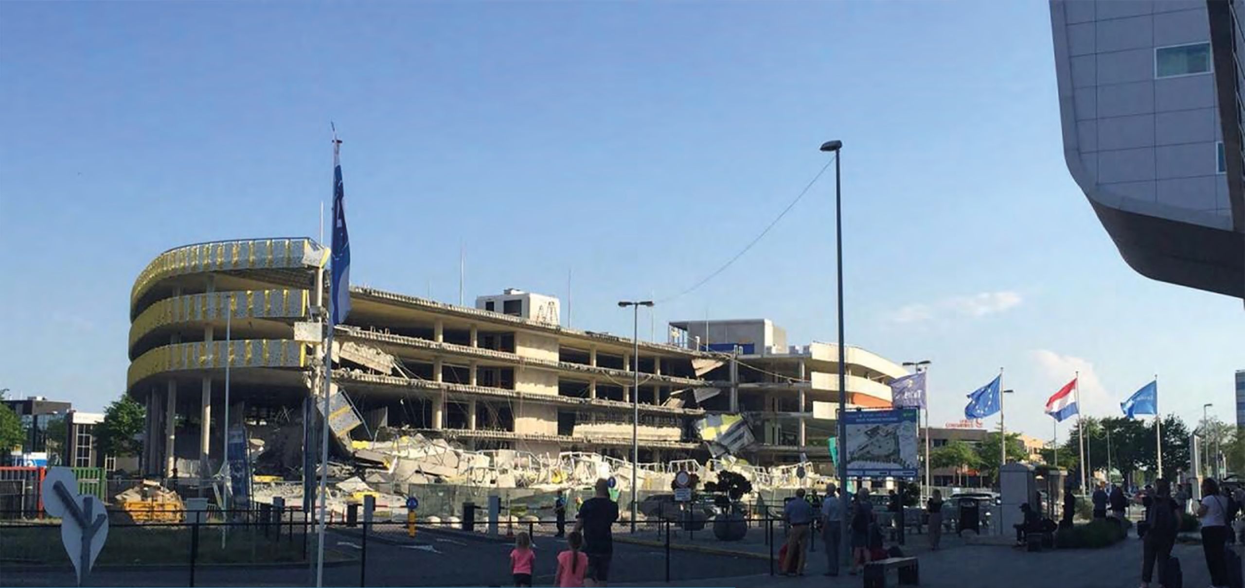
Instorting Parkeergarage Eindhoven, 2017
