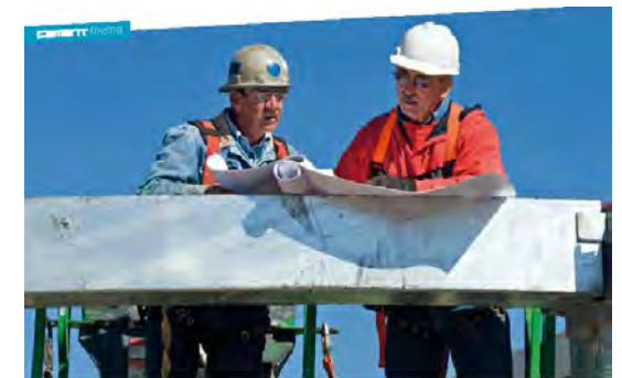
Nieuwe stap richting robuuste bouwwerken
