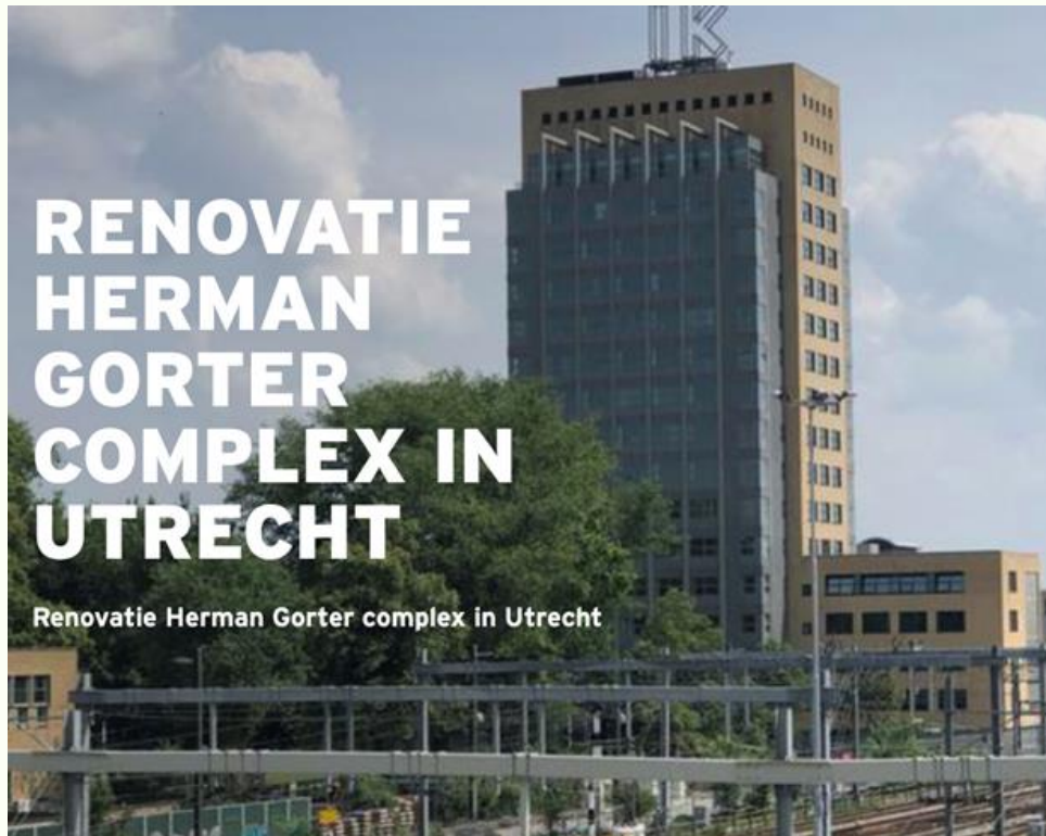
Renovatie Herman Gorter Complex
