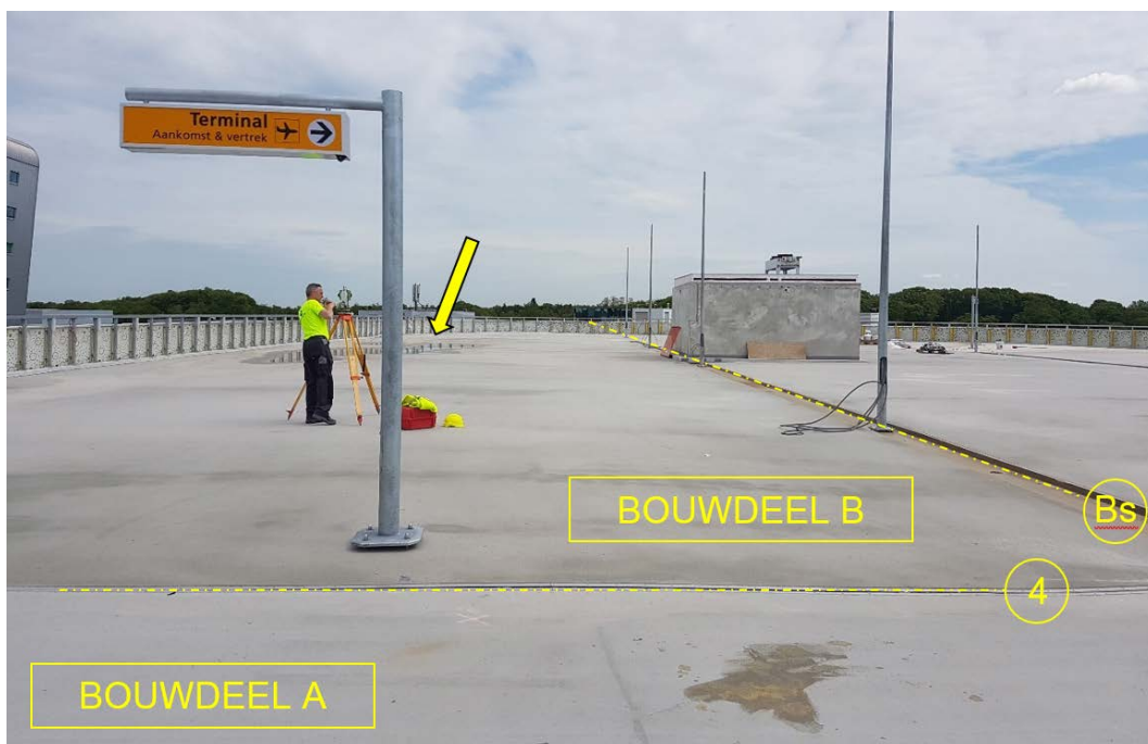
foto 3 Plas aanwezig op dakvloer bouwdeel B tussen kern en gevel op as A [72]
