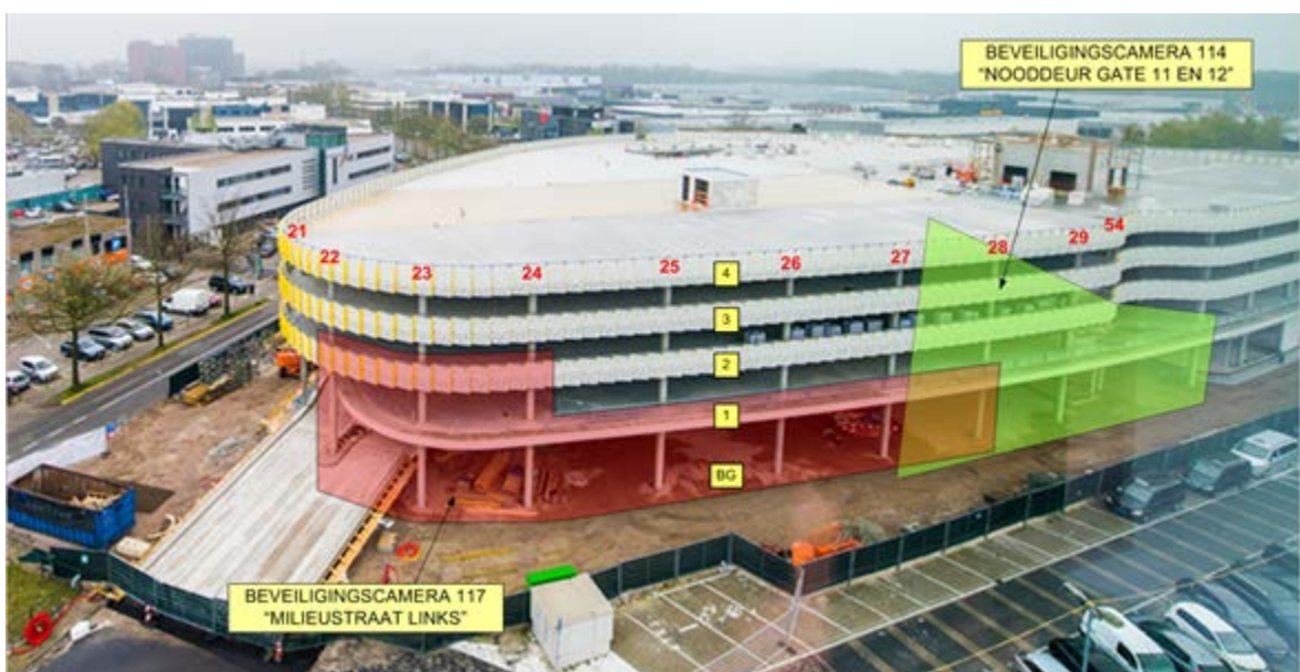
figuur 11 Zichtbare delen van de parkeergarage ten tijde van de instorting
