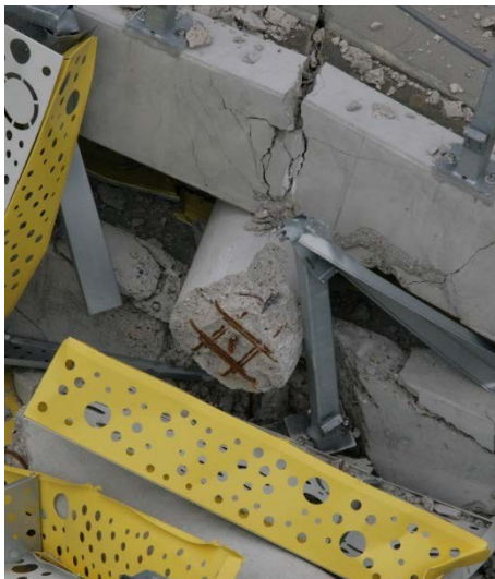
foto 9 Kolom tussen 3 e en 4 e verdiepingvloer
